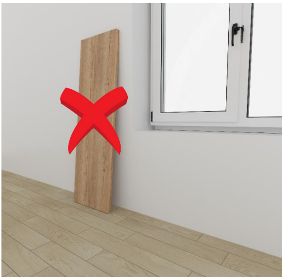
Рис. 5.1. Неправильне зберігання підвіконня.
